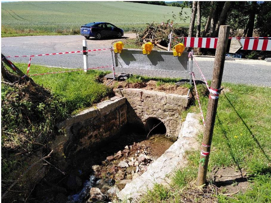
Foto 7: Dieffenbach in Abschnitt 4 mit einem zu kleinen, biologisch nicht durchgängigen Durchlassbauwerk
