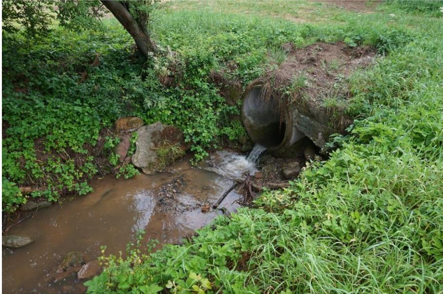
*Foto 10: Linear nicht durchgängiges Durchlassbauwerk am oberen Ende des Gewässerabschnittes*
