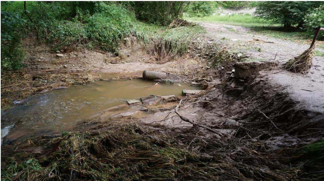
Foto 4: Die zu kleinen Durchlassbauwerke sind beschädigt oder vollkommen zerstört. Sie sind überwiegend linear nicht durchgängig.
