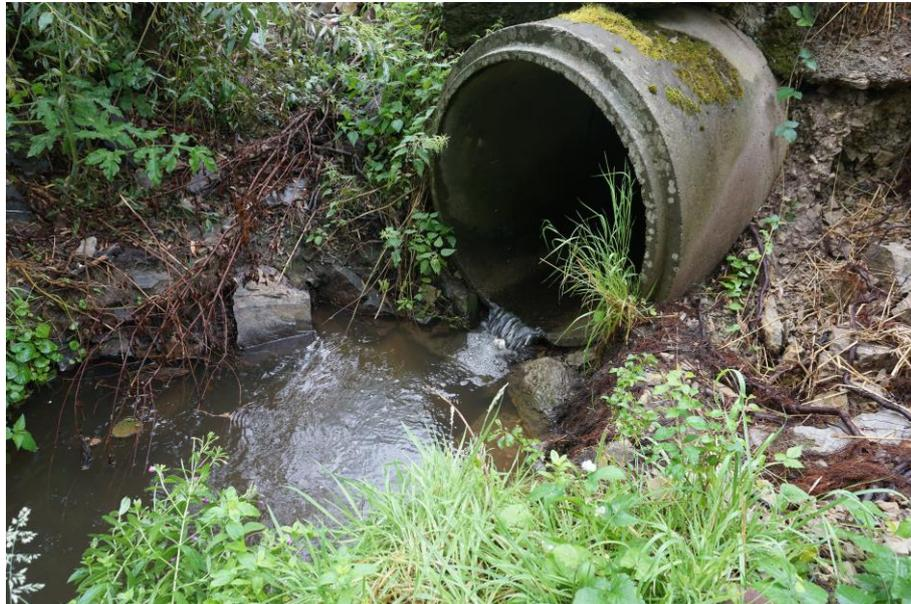
*Foto 11: Linear nicht durchgängiges Durchlassbauwerk bei Bach-km 2.40*
